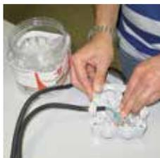
Inserimento del giunto della connessione elettrica nel gel.
