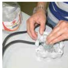
Copertura del giunto della connessione elettrica con il gel.
