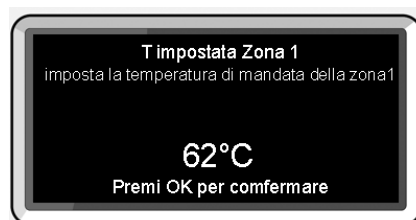
Modifica temperatura acqua calda riscaldamento
