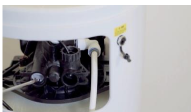
Sostituzione gomiti mandata salamoia
