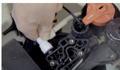
Sostituzione gomiti mandata salamoia
